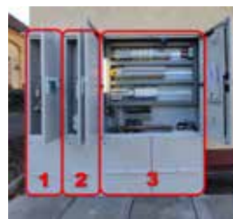
Obr. Koncept bezdrátové komunikace zapínacího místa veřejného osvětlení na nadřazený dispečink, komunikace se servisním personálem a komunikace s každým podřízeným světelným bodem. Komunikační a řídicí centrálou je tu nový Foxtrot 2 a přes jeho síť v pásmu 868 MHz lze připojovat i další senzory a přirozeně tak rozšiřovat internet věcí (IoT).
